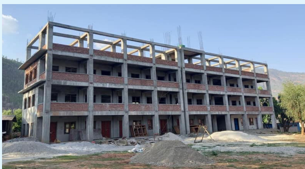
सत्यवती मा.वि.को निर्माणाधीन भवन
