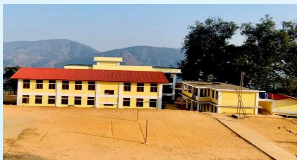
नलाङ मा.वि.को भवन
